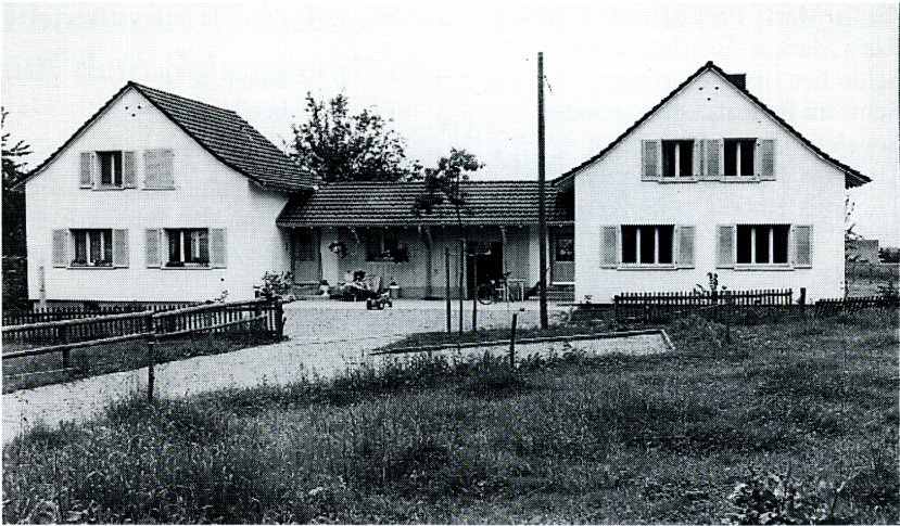
Die neu hergerichteten Häuser zeigen sich in einem freundlichen Bild.
